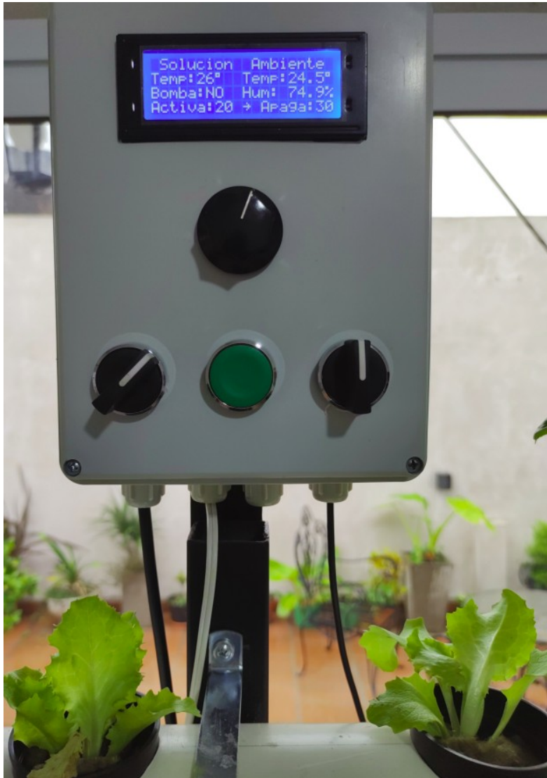
Caja de control para el sistema hidropónico.
